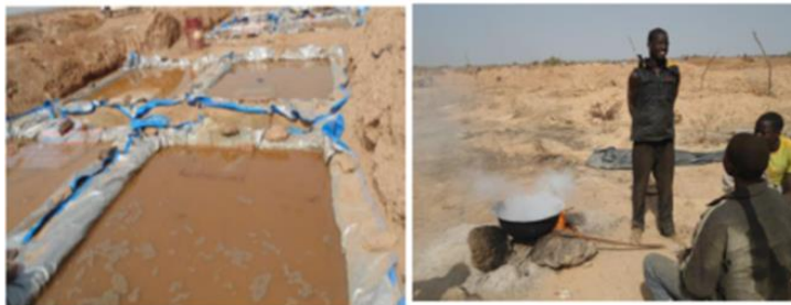
Bassins de cyanuration, site de Nbganga, Niger
